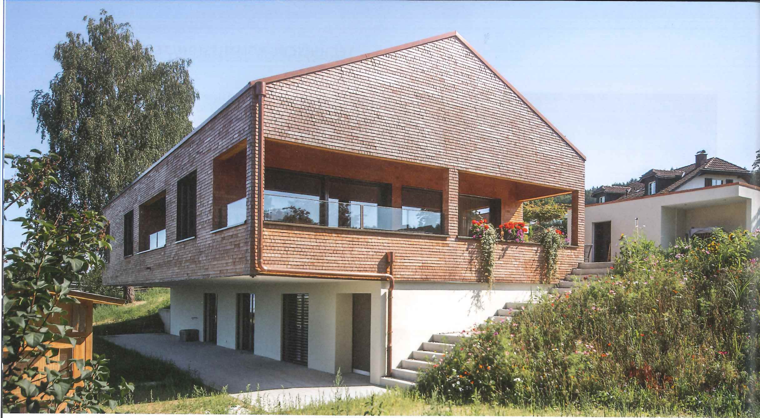
Beim Satteldach ergab sich eine ungewöhnlich flache Neigung von 25 Grad.
